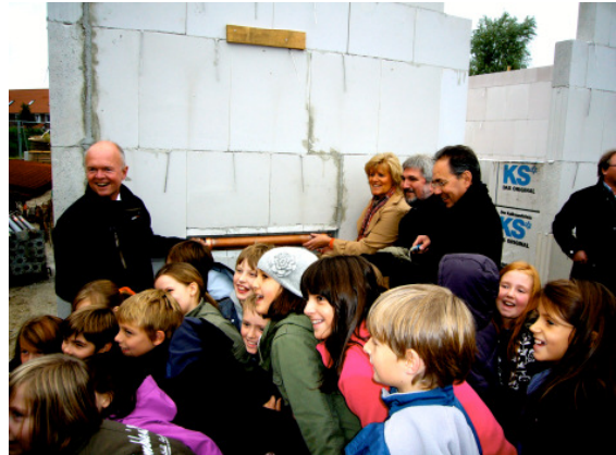
Die dicht verschlossene Kupferhülse mit den Bauplänen und einem Exemplar des Weser-Kurier vom Tage wird eingemauert.
